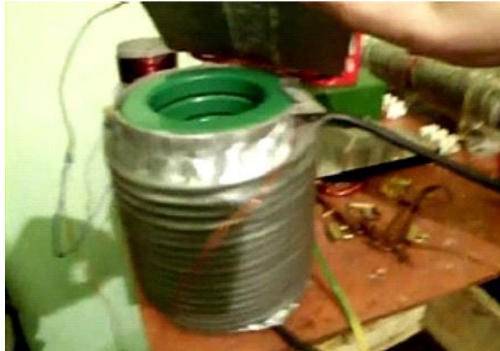
Transformador de aislamiento.
